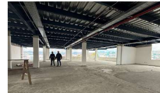
Foto b. Trabajos de adecuación y construcción en áreas internas del Edificio Administrativo.
