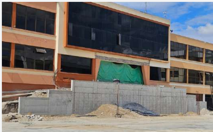
Foto a. Avance de la remodelación del Graderío Central del Edificio Cornelio Merchán.
