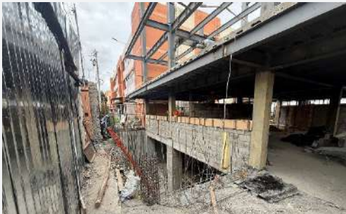
Foto b. Vista desde el nivel de subsuelo del Edificio Académico, destinado a parqueaderos.
