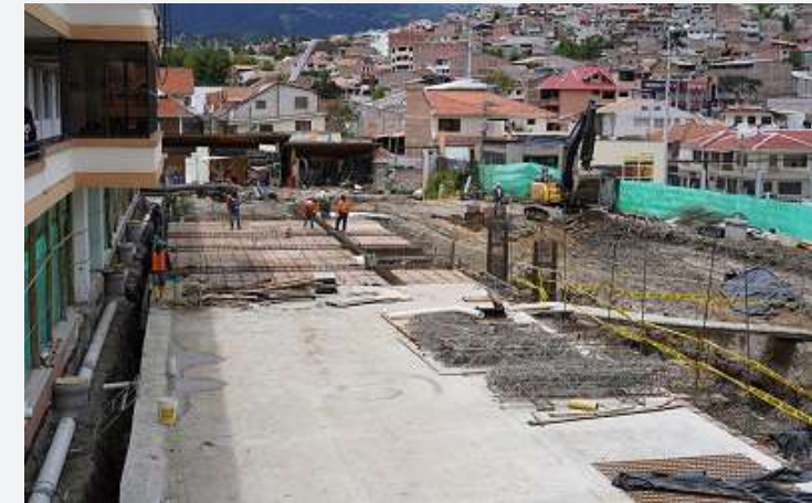
Foto a. Avance de la construcción del Parqueadero Mario Rizzini.
