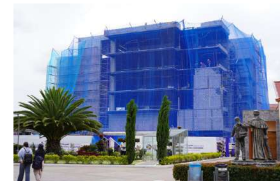
Foto c. Vista general del Edificio Administrativo durante el proceso de construcción. Fuente: UPS – Vicerrectorado General
