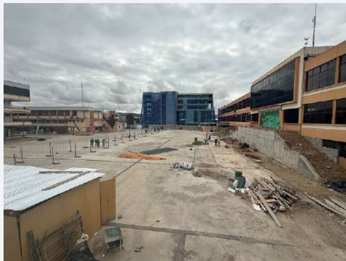
Foto b. Vista del progreso de los trabajos de remodelación del Graderío Central del Edificio Cornelio Merchán.
