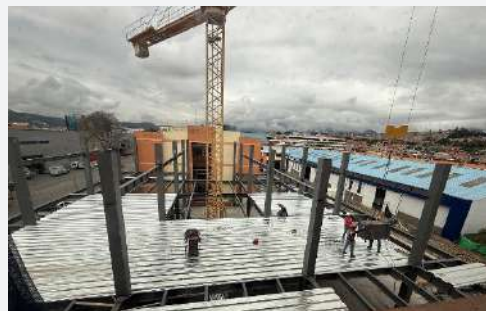
Foto c. Avance de la estructura de los pisos del Edificio Académico.
