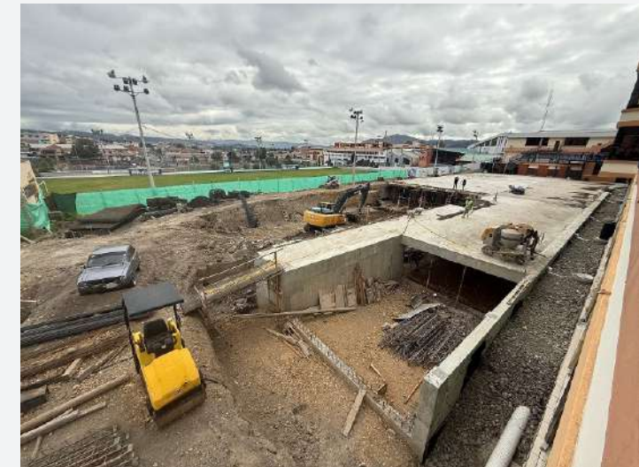
Foto b. Vista del avance de obra en la construcción del Parqueadero Mario Rizzini.
