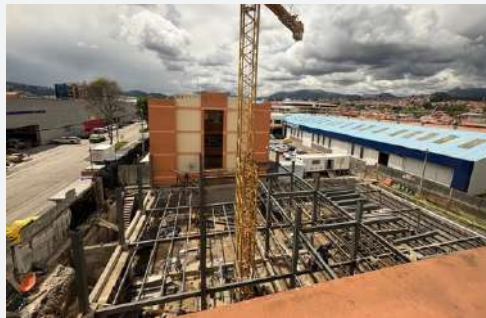
Foto a. Avance de la obra del Edificio Académico.
