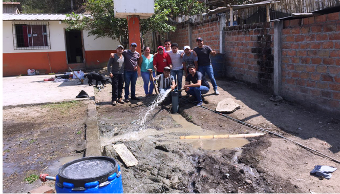
Estudiantes, graduados, profesor y miembros de la comunidad San Isidro durante las pruebas de funcionamiento de la planta de tratamiento de agua potable
